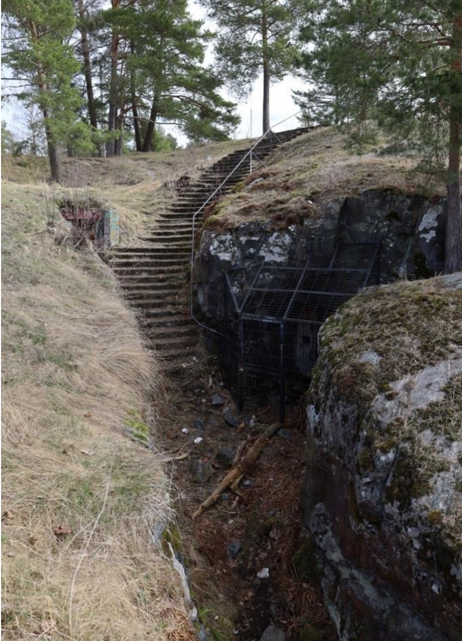
Kuva 4-2. Linnoitusrakenteisiin kuuluva portaikko johtaa kapeaan ja roskaiseen hautaan. Luolan sisäänkäynti on suljettu verkolla, mutta se ei ole riittänyt estämään luvaton käyttöä. Vasemmalla näkyy toisen maanalaisen tilan sisäänkäynnin kulma. Myös tämä tila on houkuttellut roskaajia ja töhrijoita.
